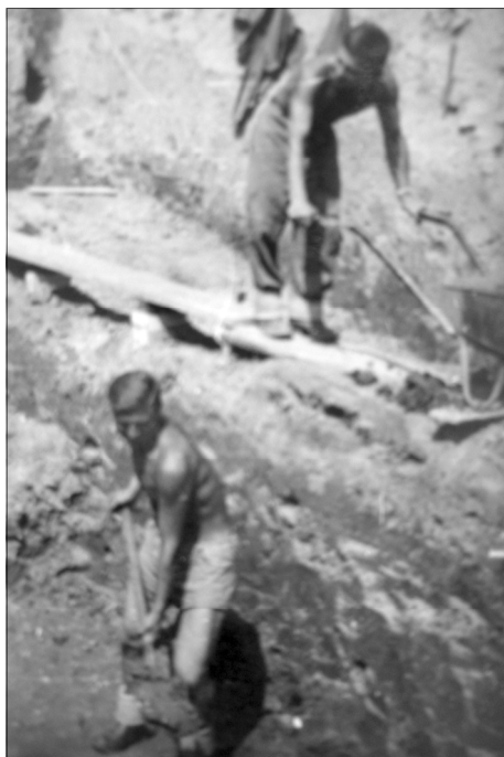
Bartoszyce 1966 – 1968. Prace ziemne, wykop pod dom mieszkalny. U dołu Edmund Sikorski sypie łopatą piach do taczki.
