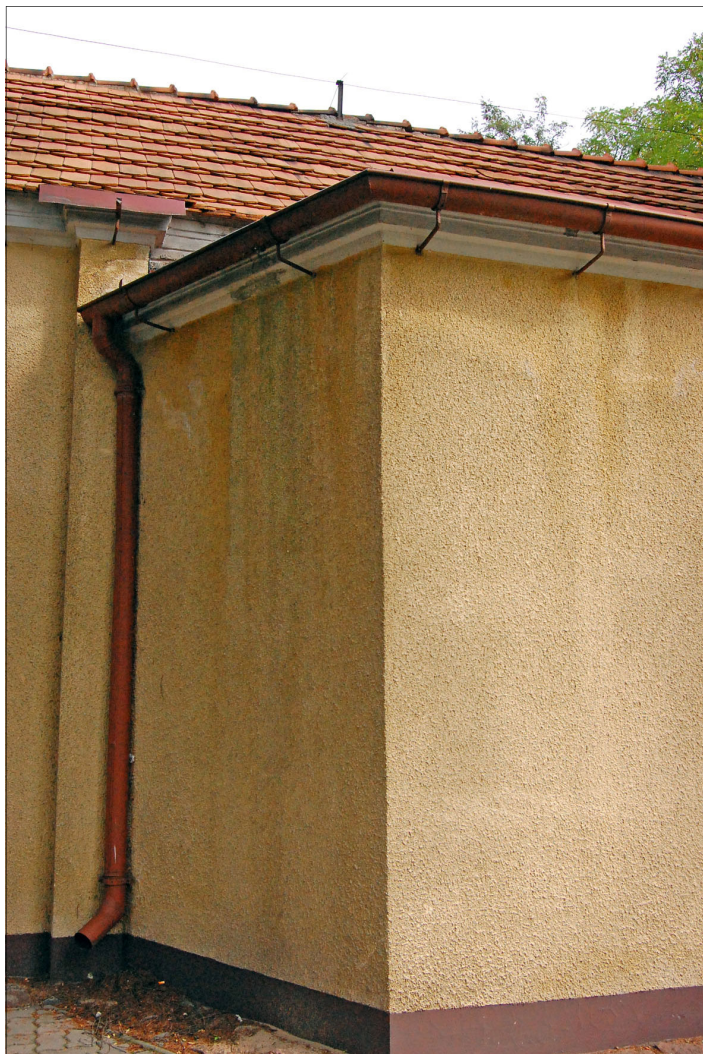
Przebiegające rynny spowodowały uszkodzenie elewacji.
